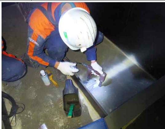
위 치 거더 내부 내 용 자분탐상 시험
