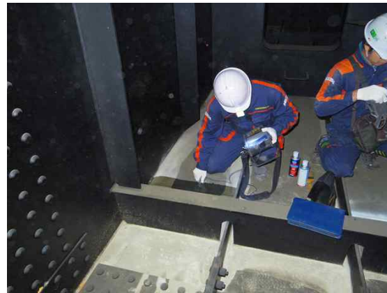
위 치 거더 내부 내 용 강재 초음파 탐상
